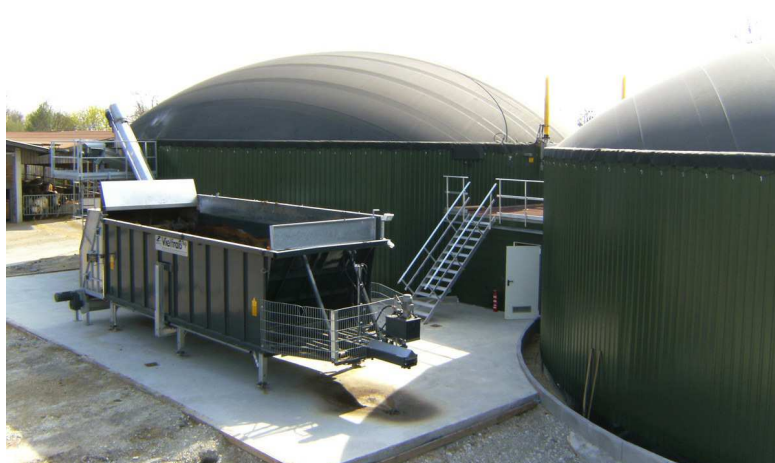
Obr. 24: Jednomembránové plynojemy Agrikomp - Biolene
