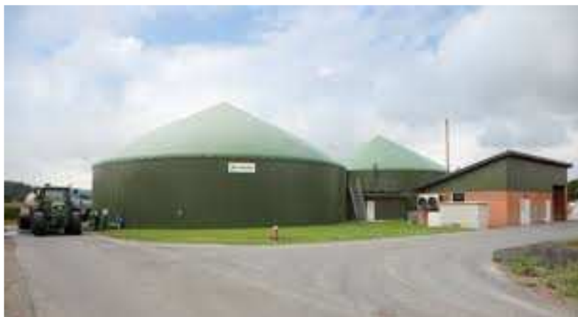
Obr. 20: Suché dvoumembránové plynojemy nasazené na fermentorech zemědělské BPS
