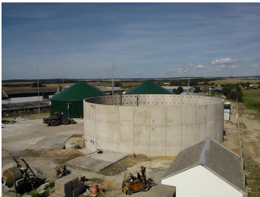
Obr. 33: Uskladňovací nádrž surového digestátu (Concretebau)
