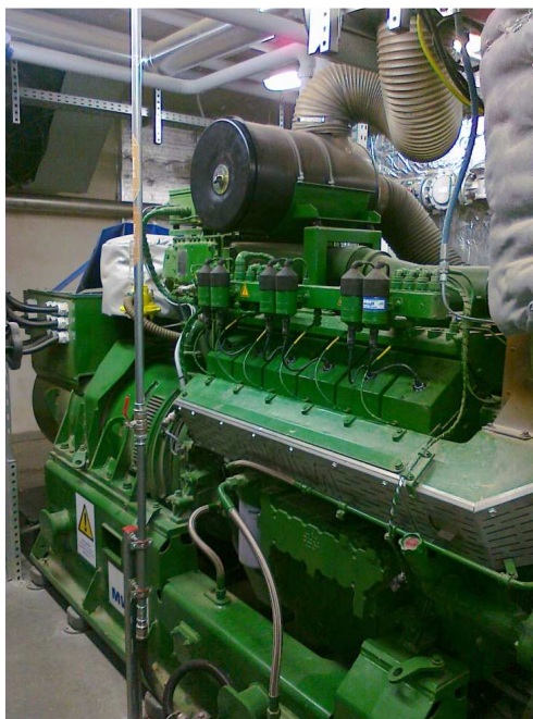
Obr. 17: Zážehový motor kogenerační jednotky (MWM Deutz)
