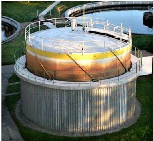
Obr. 19: Mokrý plynojem pro jímání kalového bioplynu na ČOV
