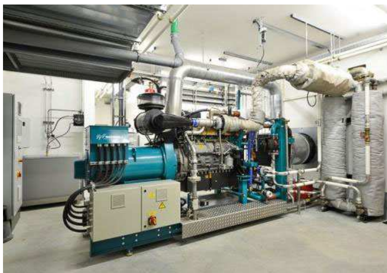
Obr. 18: Dvoupalivový vznětový motor KJ Schnell
