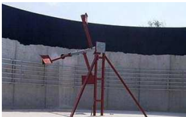
Obr. 7: Pomaloběžné pádlové míchadlo (stavba BPS Bukovec)
