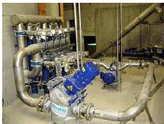
Obr. 9: Systém centrálního čerpadla a rozvaděče materiálu na BPS s macerátorem
