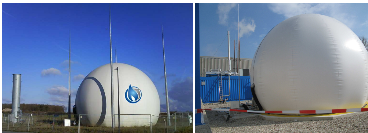
Obr. 30, 31: Příklady samostatně stojících plynojemů, Bioproject, Sattler
