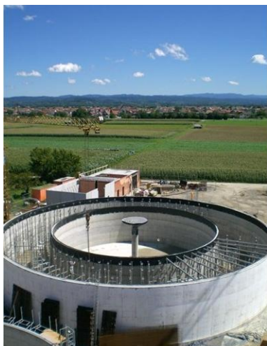
Obrázek 3.2: Výstavba fermentoru „kruh v kruh“, [19].
