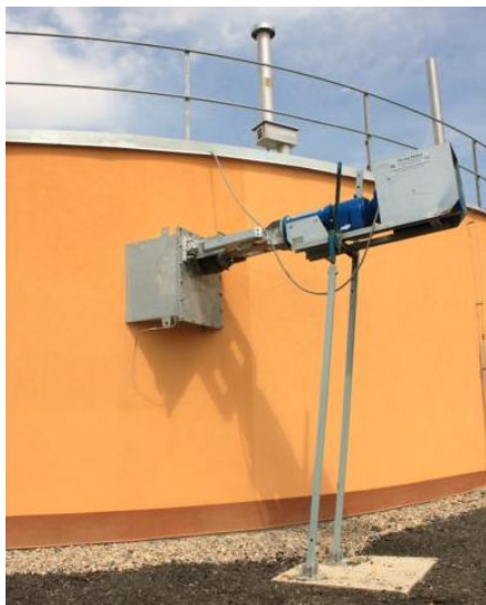
Obrázek 3.11: Boční vrtulové míchadlo, [23].
