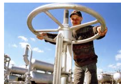
Kondicionování (LPG) Stlačení Odorizace
